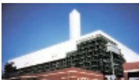
板橋清掃工場
