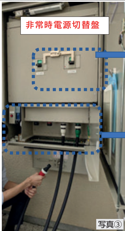
(写真) 電力設備のかさ上げ・非常時電源切替盤の設置状況
