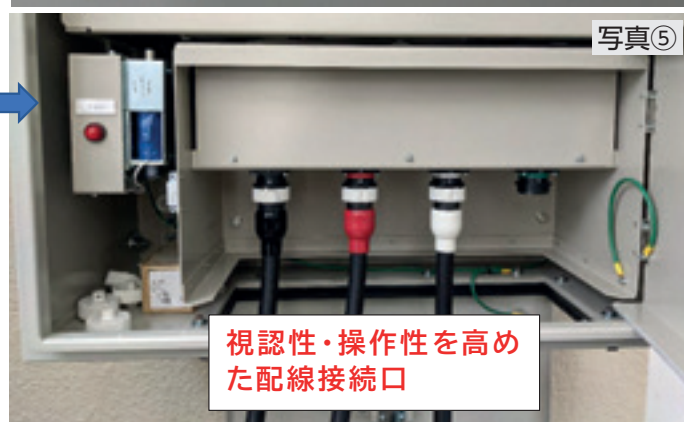
(写真) 電力設備のかさ上げ・非常時電源切替盤の設置状況
