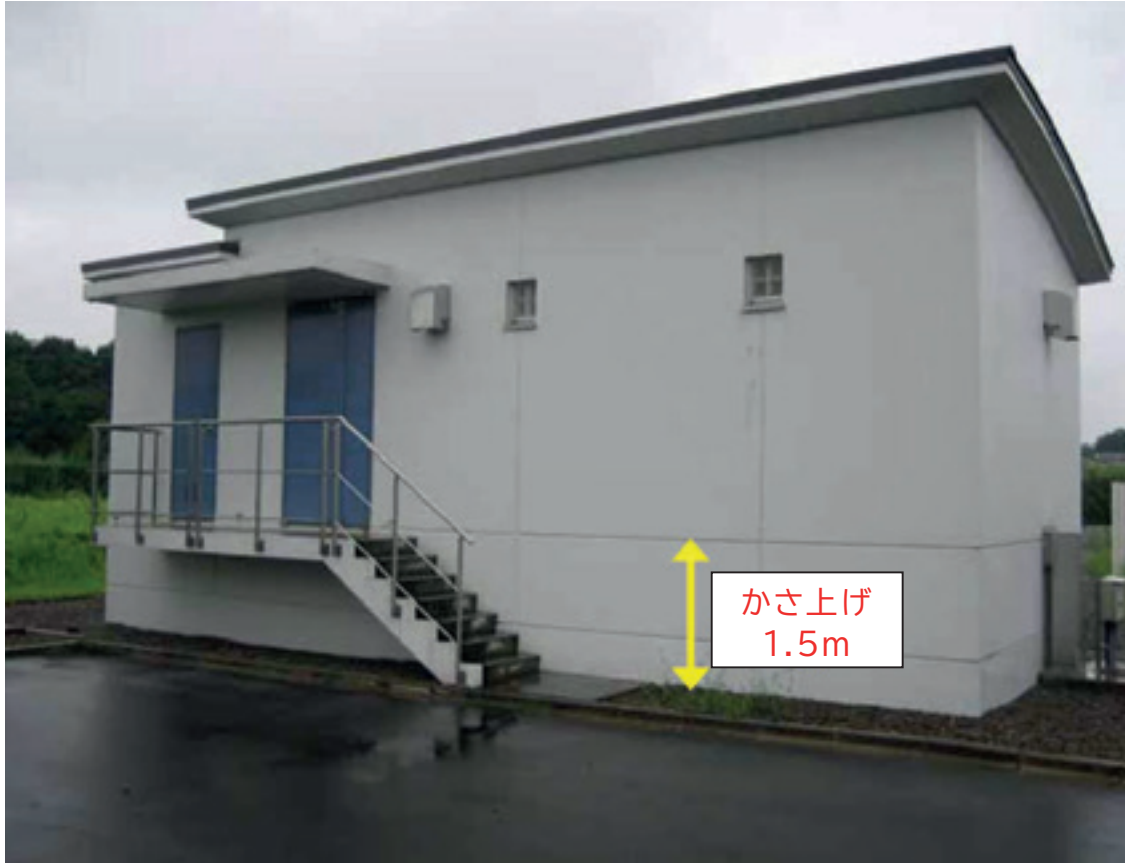
(写真) 拠点施設 付帯設備のかさ上げ例 21
