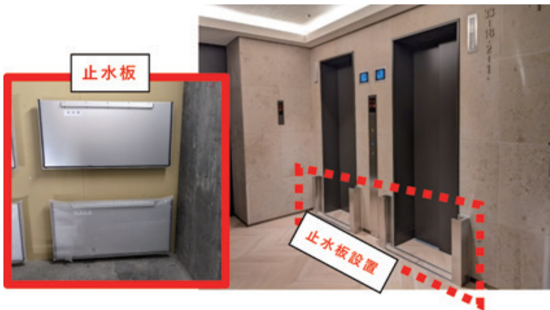
(写真) エレベーターへの止水板の設置
