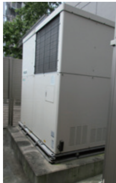
(写真) トミンハイム横川一丁目・自立型発電設備 (コージェネレーションシステム)
