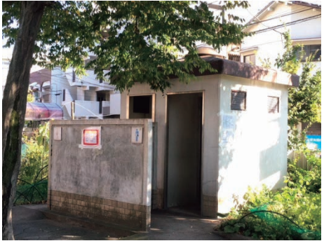
改修前の公園トイレ
