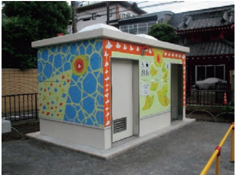
改修後のアートトイレ
